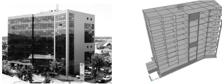
Fig. 1 – Tudor Office Center, Iași.
