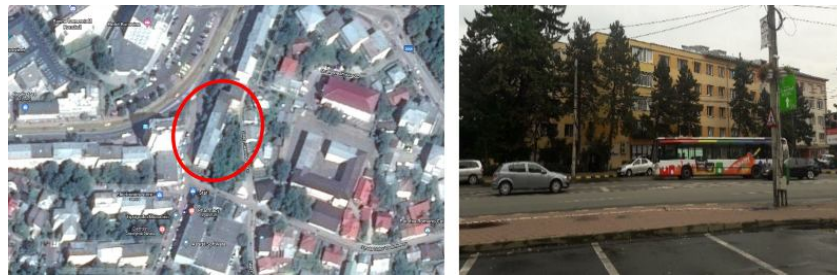
Fig. 2 – Location – Block D1 located on Ipătescu Str., Mun. Suceava.
